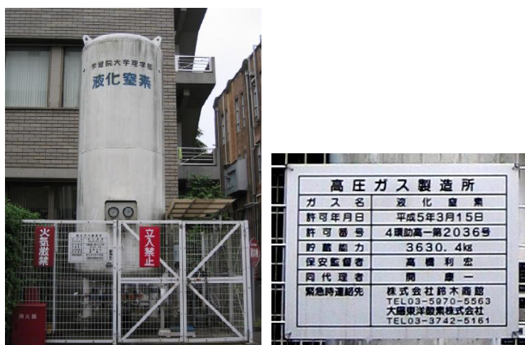
図 7. 学習院大学が保有する液化窒素用コールドエバポレータ。
